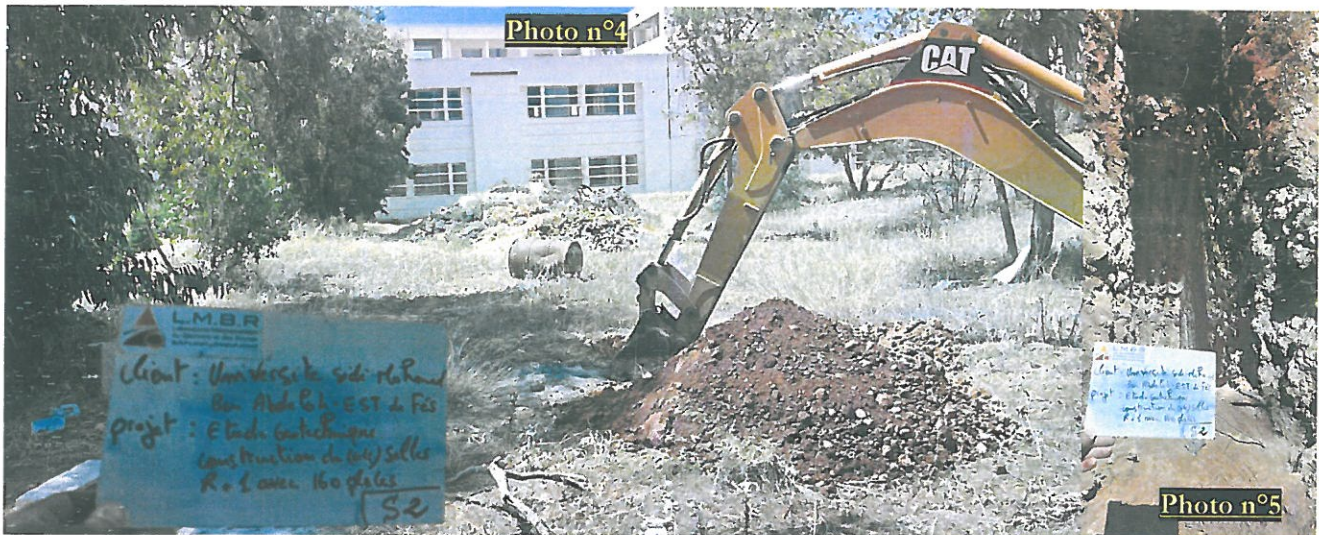
Photos : Montrant les travaux de la réalisation du sondage mécanique Sm2
