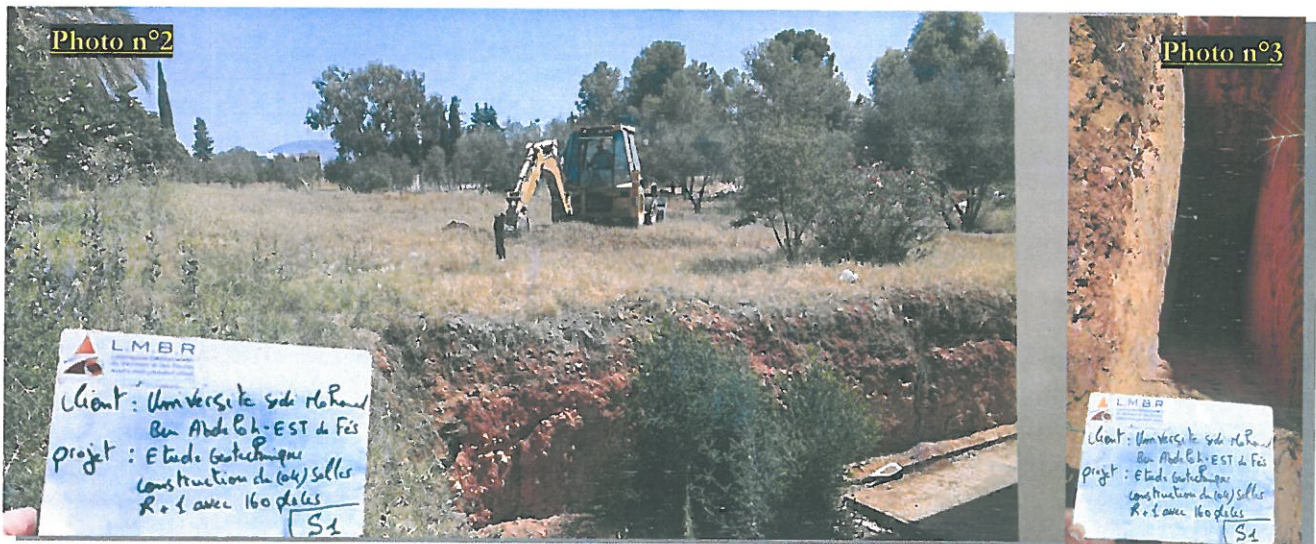
Photos : Montrant les travaux de la réalisation du sondage mécanique Sm 1
